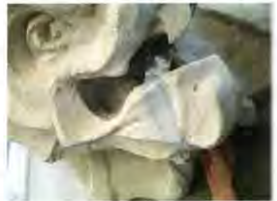
Il muso dello stesso drago mentre gli viene applicata, dopo l'inserimento e la sigillatura di adeguati perni passanti, anche una sottile quanto robusta cerchiatura di rinforzo.
