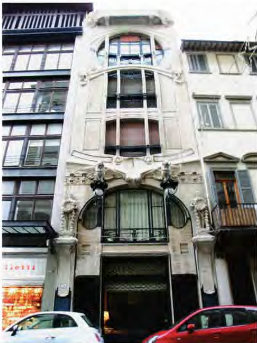
La facciata in travertino artificiale della Casa-galleria Vichi a Firenze dopo il suo complesso, recente restauro.
