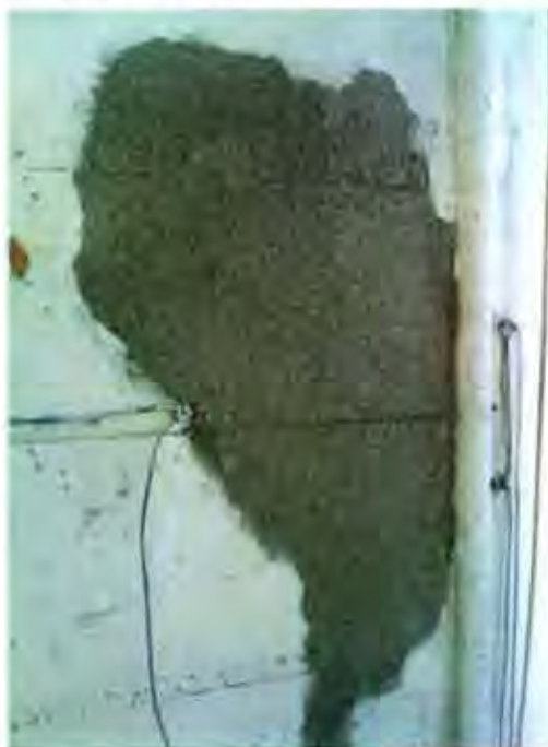
Un ferro di armatura esposto, già ripulito e trattato con passivante/antiossidante epossidico.
