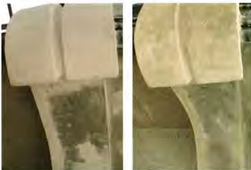
La stessa mensola, prima e dopo il suo adeguamento cromatico, come di prassi realizzato doverosamente sottotono.
