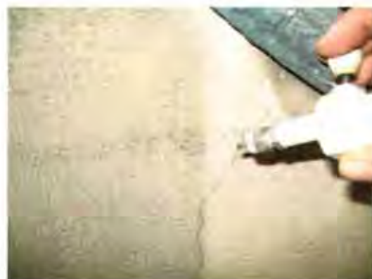
Una fase di pulitura eseguita a microsabbiatrica con pressione mai superiore a 0,5 bar. Si tratta di un'operazione delicata, da affidare perciò, esclusivamente, a restauratori di comprovata perizia ed esperienza.
