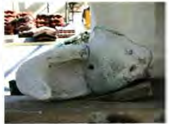
Ricomposizione della plasticità originale di uno dei due draghi, la cui stabilità è stata garantita dall'inserimento di apposite armature passanti (barra in vetroresina) e da una tenace colla epossidica.
