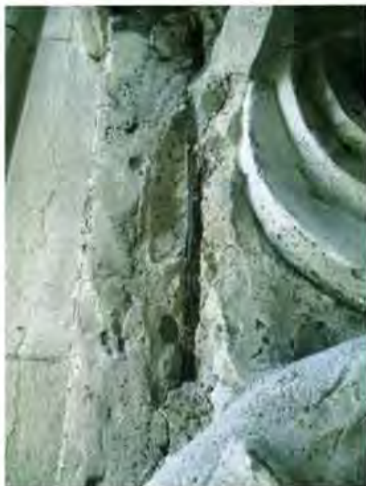
Un ferro di armatura esposto, già ripulito e trattato con passivante/antiossidante epossidico.
