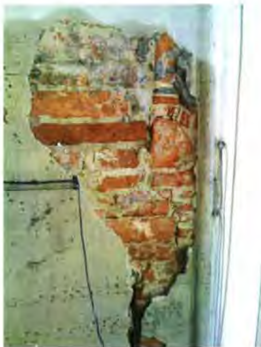
Un brano di muratura rimessa in luce a seguito della rimozione dell'intonaco soprastante, a cui si è provveduto dopo aver verificato che la sua totale instabilità lo rendeva di fatto irrecuperabile.
