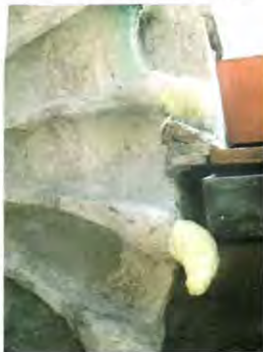
Un brano di muratura rimessa in luce a seguito della rimozione dell'intonaco soprastante, a cui si è provveduto dopo aver verificato che la sua totale instabilità lo rendeva di fatto irrecuperabile.
