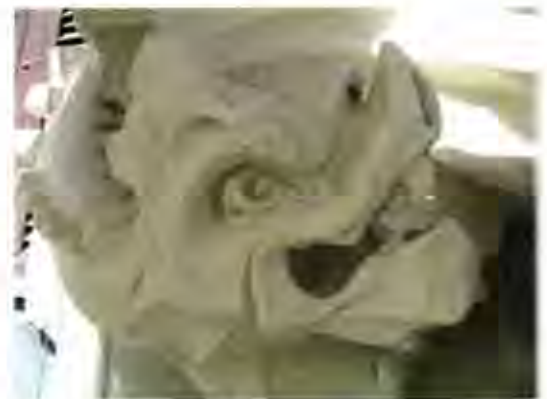
L'assoluta omogeneità materica dei rappezzi rispetto ai manufatti originali, ottenuta mediante la sapiente applicazione di velo finale congruamente pigmentato.
